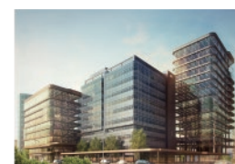
암스테르담 The Atrium 1,2,3 (네덜란드)
